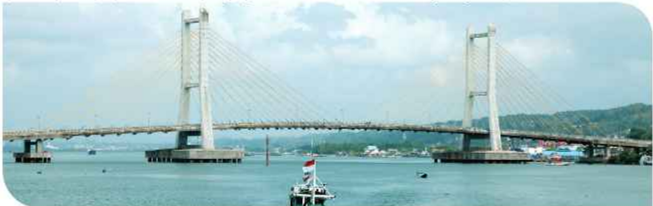
Jembatan Teluk Kendari | Jembatan Teluk Kendari adalah sebuah jembatan kabel pancang di Kota Kendari, Sulawesi Tenggara yang melintasi Teluk Kendari dan menghubungkan Kecamatan Kendari dengan Kecamatan Abeli di sisi selatan teluk.
